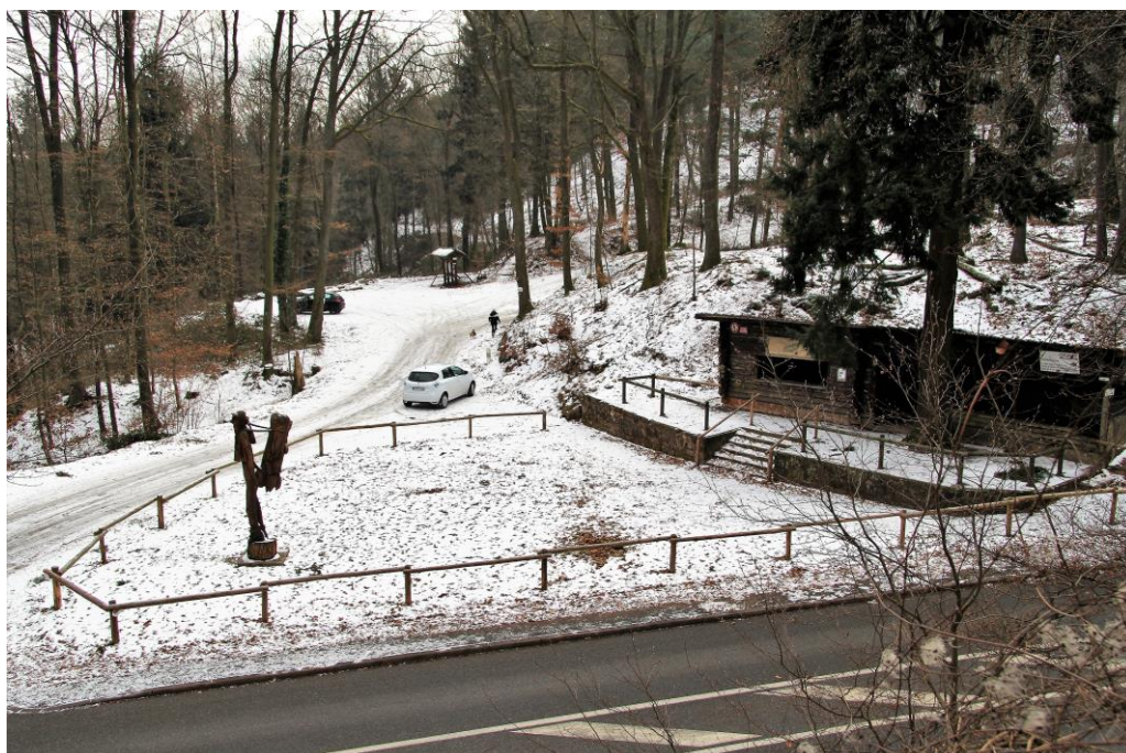
Vue d'ensemble sur l'abri du col réaménagé
