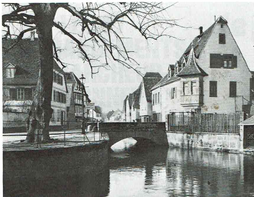
Wissembourg - Le Bruch et la maison dite de l'Ami Fritz
