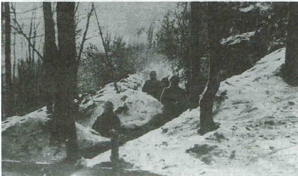
Tranchées françaises à l'Ouest d'Obersteinbach (début 1940)
